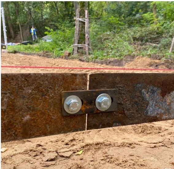
Zdjęcie poglądowe łączenia płaskowników. Fot. topoScape.
